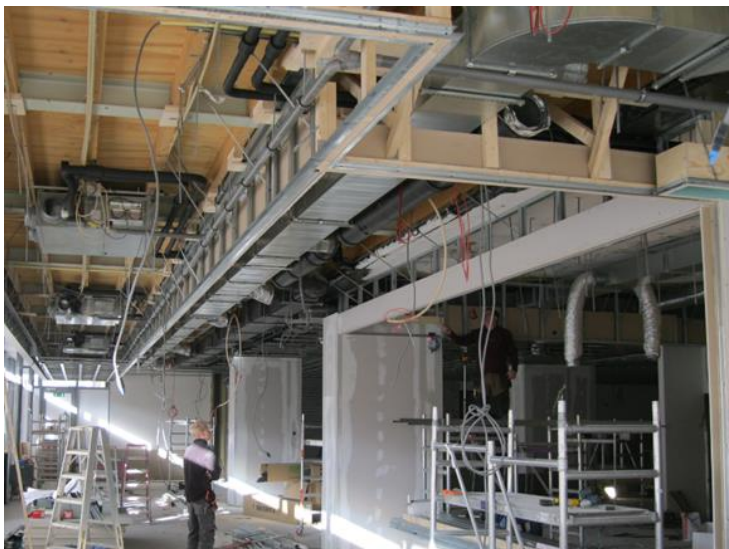
Fase 4 / Renovatie van restaurantfaciliteiten + aangrenzende zalen:
