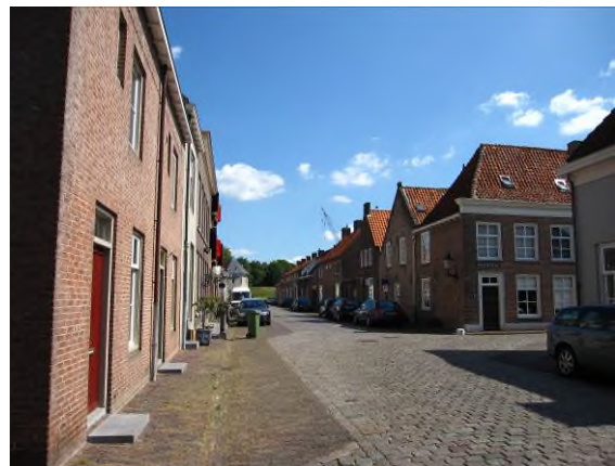
Putterstraat: zoveel mogelijk bestaande dakpannen hergebruiken
