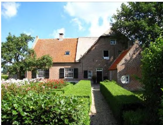
Grotestraat, Heesbeen: aanbouw ondergeschikt aan de hoofdvorm
