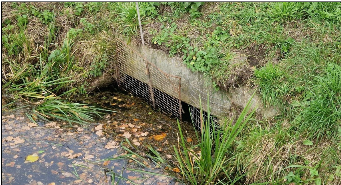
Figuur 7. In een duiker bij de Biesheuvellaan in Vlijmen is een rooster geplaatst. Omdat bevers zich bij voorkeur verplaatsen via water (ook door duikers) werkt dit ontmoedigend op de vestiging van bevers.
